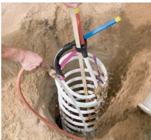
Einbau einer RAUGEO Helix PE-Xa
