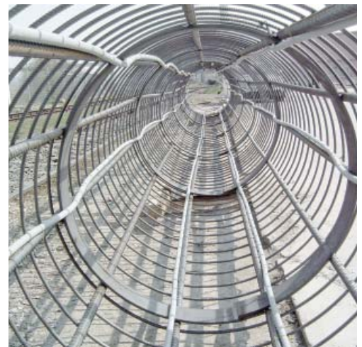
Energiepfahl vor dem Einbau
