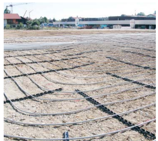
Verlegung der RAUGEO Erdwärmekollektoren
