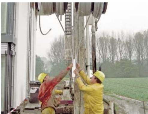
Einbau einer RAUGEO Erdwärmesonde
